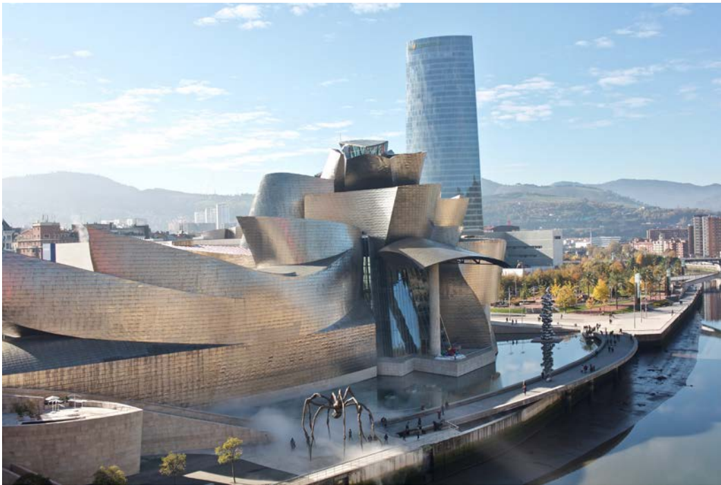
Figura 2- Edificio Guggenheim de Bilbao. Arquitecto Frank Gehry Fotografía de Naotake Murayama from San Francisco, CA, USA – Museo Guggenheim, Bilbao, CC BY 2.0, https://commons.wikimedia.org/w/index.php?curid=54782250
